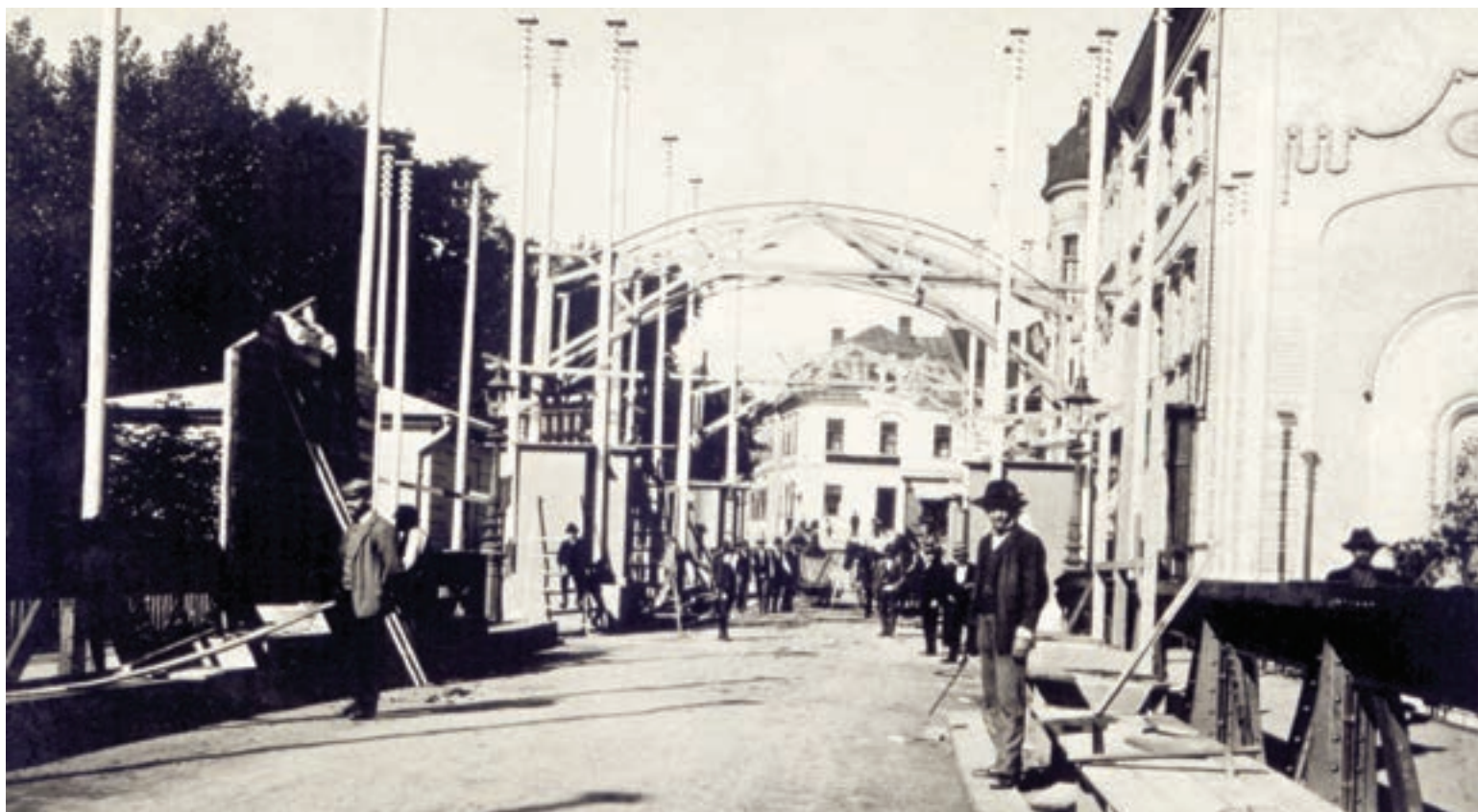
← Stavba vítězné brány na Hlavním mostu
