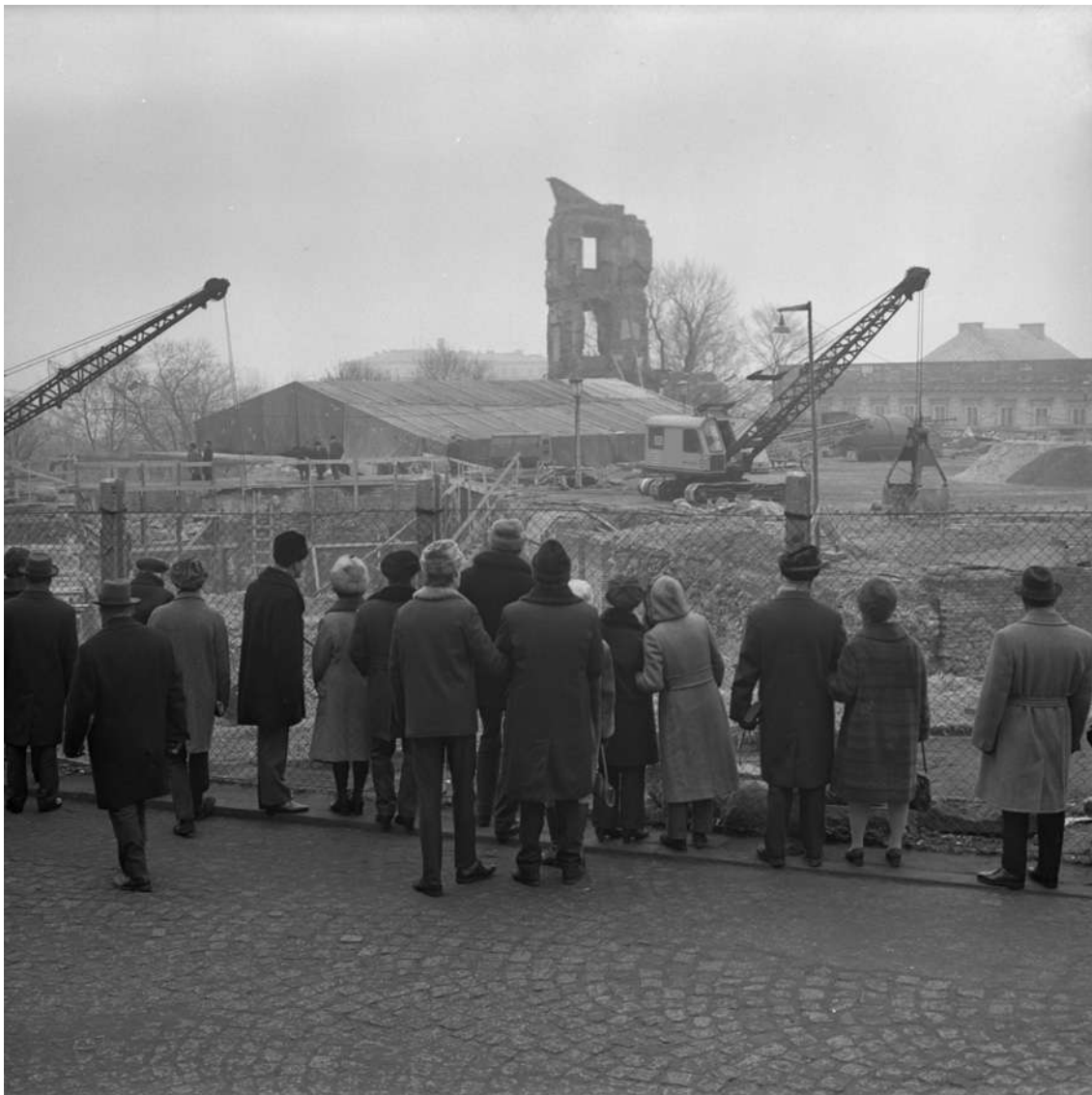
◀ Warszawa, luty 1972. Odbudowa Zamku Królewskiego. FOT. LUBOMIR T. WINNIK / ZBIORY FUNDACJI OŚRODKA KARTA
